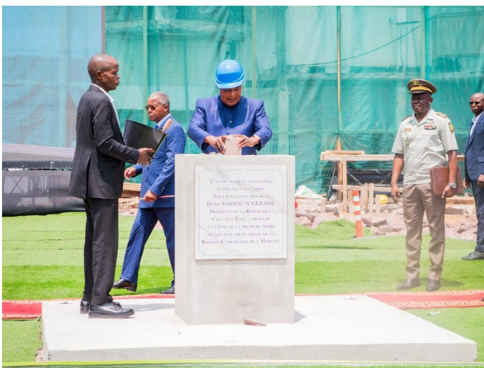
Le chef de l'Etat lance les travaux de construction du siège de la BCH
